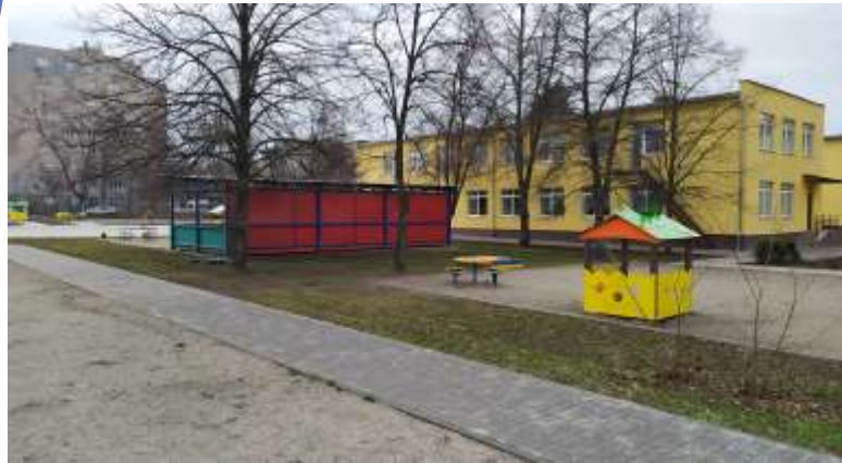
КАПІТАЛЬНИЙ РЕМОНТ ДНЗ №217 ПО ВУЛИЦІ БОЧАРОВА, 14-Б МІСТО ЗАПОРІЖЖЯ
