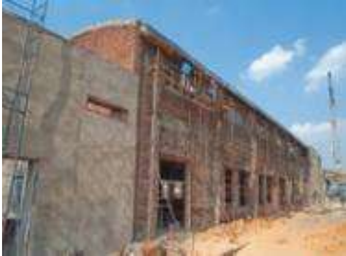
БУДІВНИЦТВО ХІМВОДООЧИСТКИ КОГЕНЕРАЦІЙНОЇ УСТАНОВКИ
