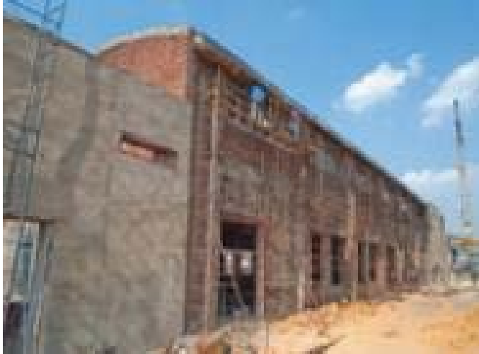
БУДІВНИЦТВО ХІМВОДООЧИСТКИ КОГЕНЕРАЦІЙНОЇ УСТАНОВКИ
